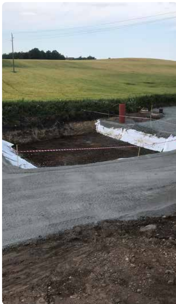
Schakt för pumpstation Saleby i Vartofta
